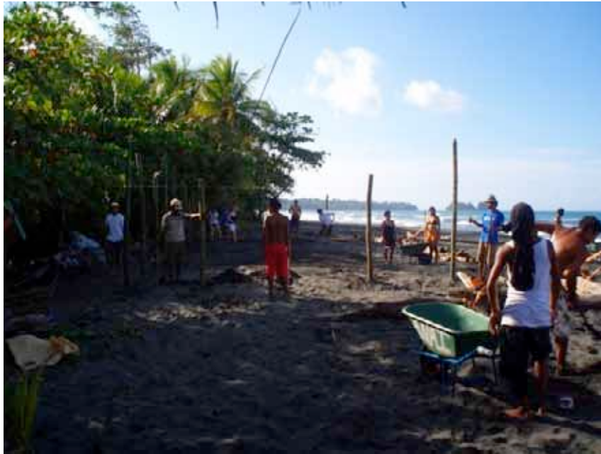
Voluntarios y personal del proyecto trabajando en la construcción del vivero.
